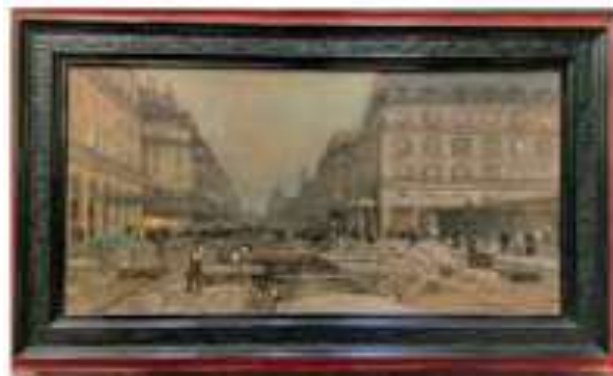
La Construction du métropolitain Luigi Loir (1845-1916), 1900
