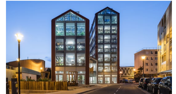
La Cité maraîchère de Romainville, ferme verticale, Ilmelgo architectes, projet nominé au prix de l'Union européenne pour l'architecture contemporaine Mies Van der Rohe 2022 © Paul Lengereau
